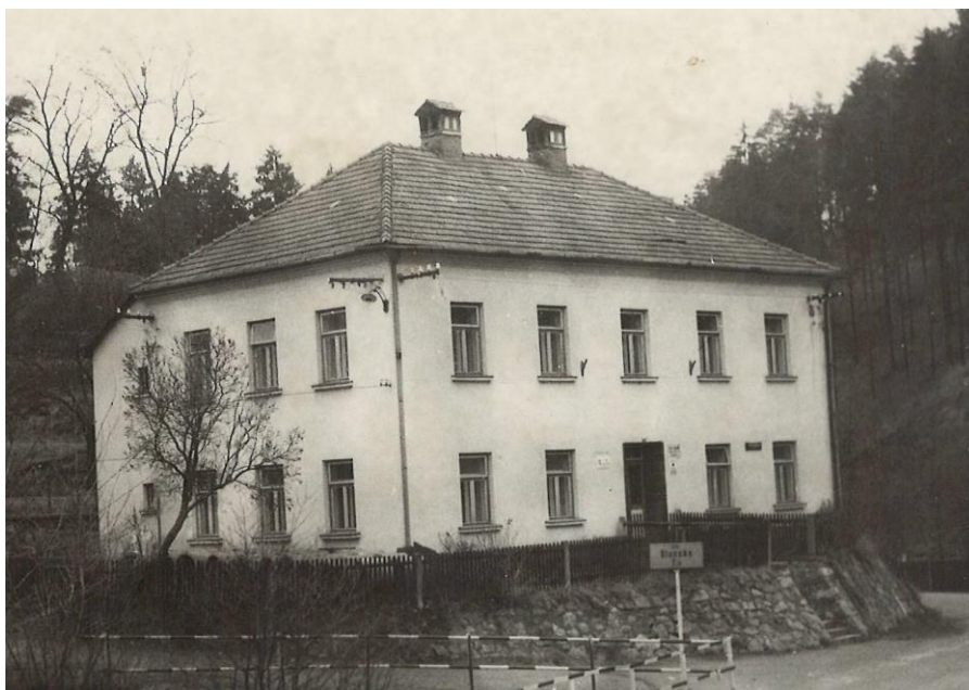
Stará škola postavená roku 1874 a opravená v roce 1945
